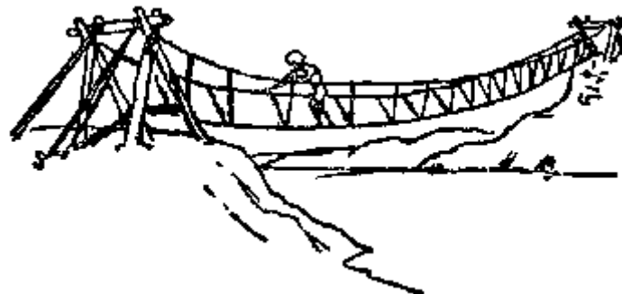
En los montes Himalaya, los nativos construyen puentes con tres cuerdas
